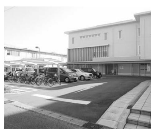
移設した駐車場
