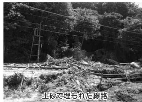
土砂で埋もれた線路
